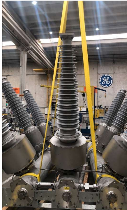
Fig. 6: Visão da amarração próximo do TC
